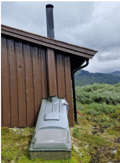
Figur 11. Bilder av en type biologisk toalett som benyttes for mange av hytte ved Eidsbugarden/Fondsbu. Anleggene er produsert av Norcem. I bildet til høyre er det oppsamling av væske/ urin i eget kammer. Bark skal normalt benyttes til oppsamling av væsken.
