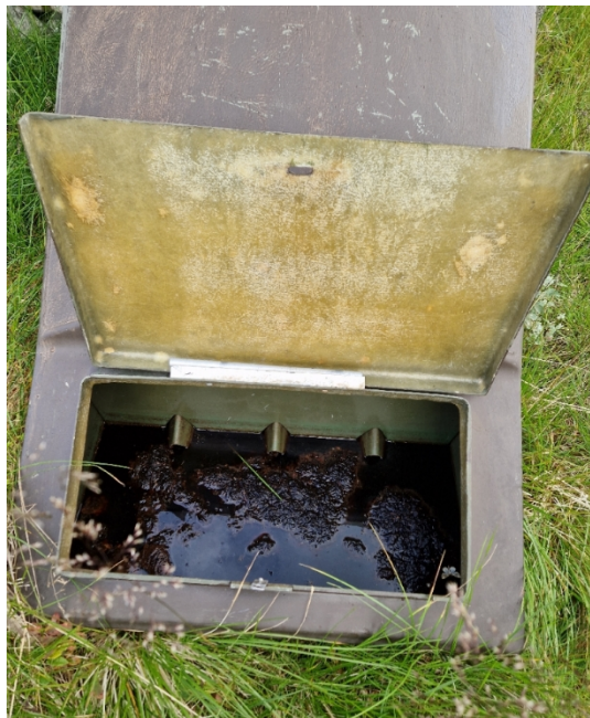
Figur 11. Bilder av en type biologisk toalett som benyttes for mange av hytte ved Eidsbugarden/Fondsbu. Anleggene er produsert av Norcem. I bildet til høyre er det oppsamling av væske/ urin i eget kammer. Bark skal normalt benyttes til oppsamling av væsken.
