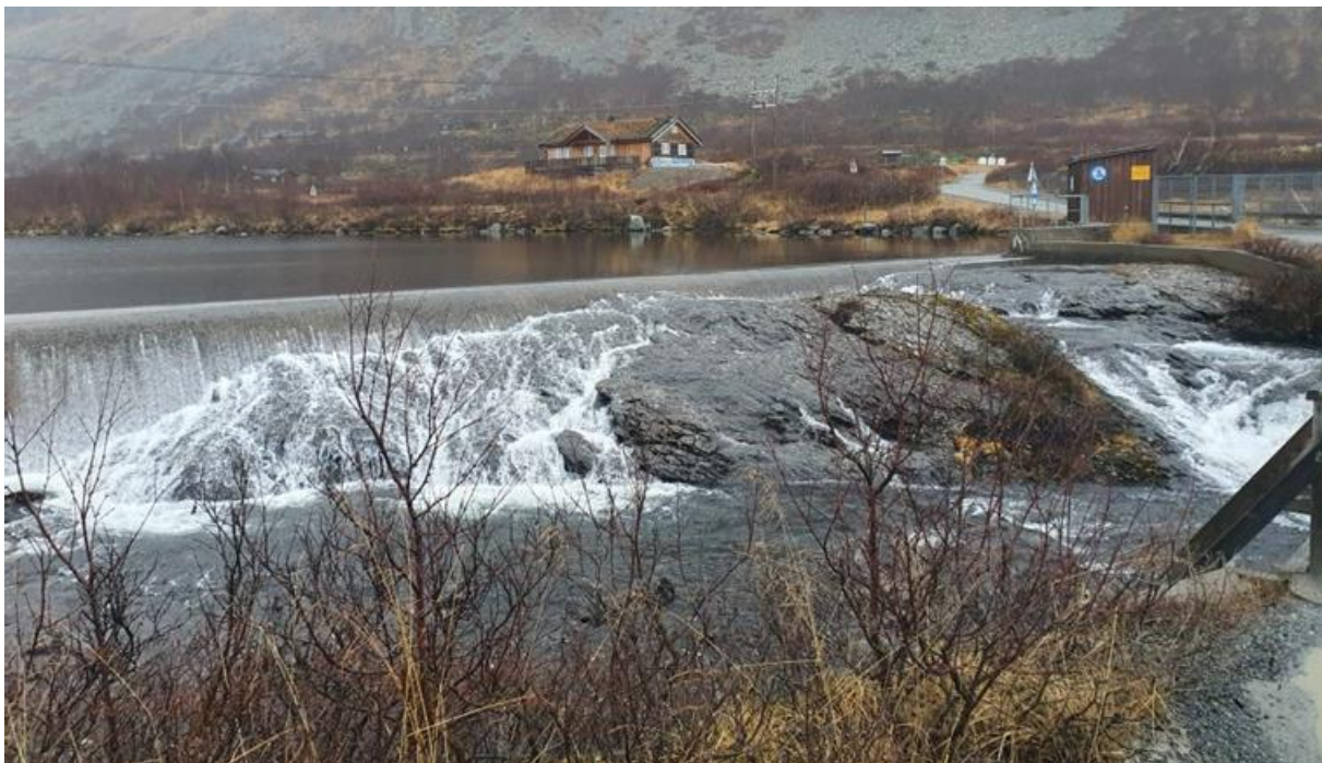
Figur 19: Overløpstærskelen ved utløpet av Otrøvatn.
