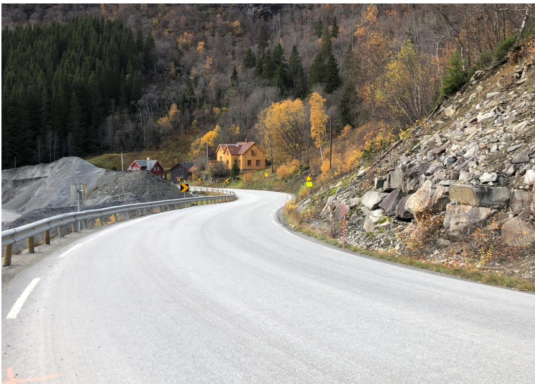
Figur 2 – Utsikt vestover langs Tynvegen ved innkjørsel til rasteplass
