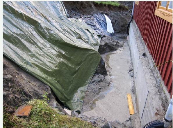
Bilde 4. Bilde fra 2011 viser ny grunnmur, betongtetting av sprekker i fjell.
