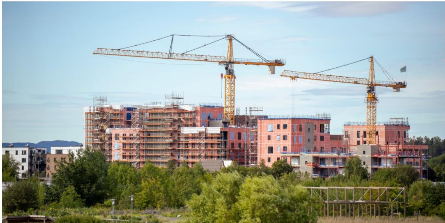
Illustrasjonsfoto, boliger under bygging på Fornebu. (Foto: Frederik Ringnes/NTB)
