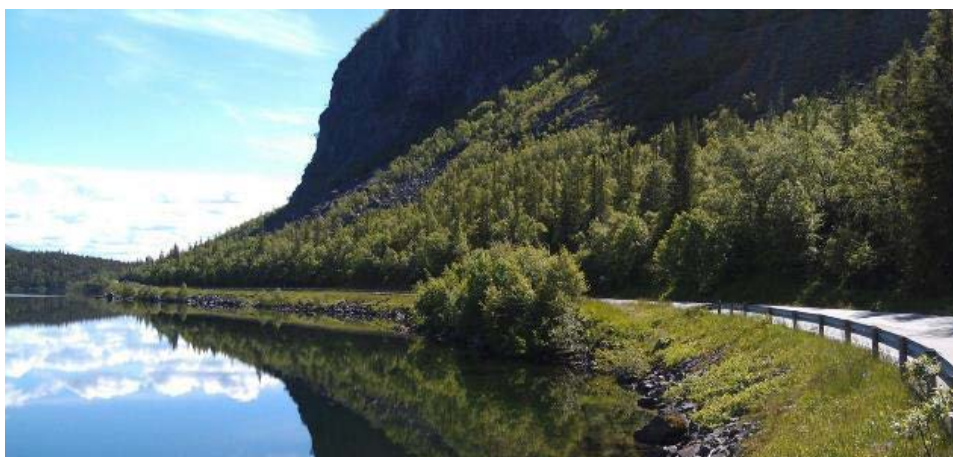
Dagens E16-fylling ut i Norsvinsfjorden i Hugavike, fotografert mot øst. Skråningen ovenfor vegen domineres av delvis skogdekt ur.
