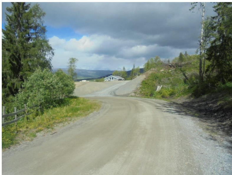
Bilde 4: Mot avkjøring fra stølsvegen.
