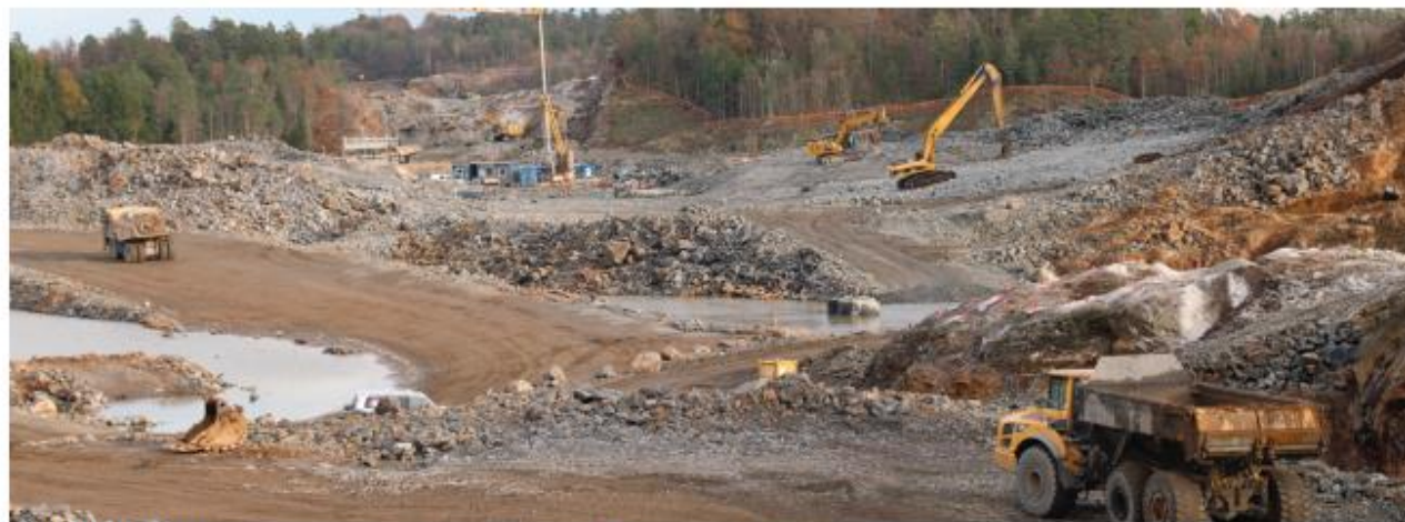
MYRVERSTING. 109 dekar myr ble ofret da 22 kilometer ny E18 mellom Tvedestrand og Arendal ble bygget i perioden januar 2017 til juli 2019.
