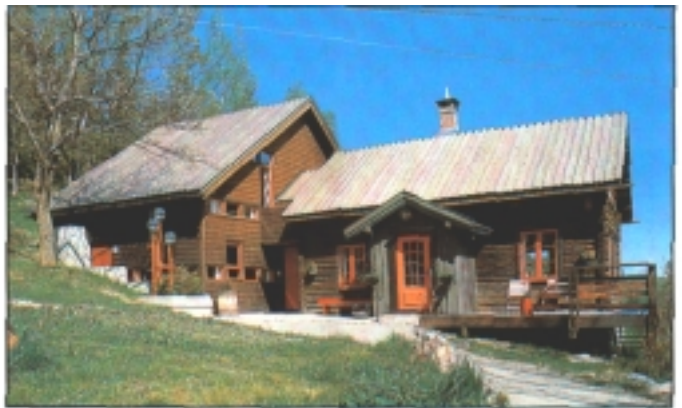
Eit lite rnellombygg mellom garnalt og nytt kan i mange høve vera ei god løysing. Lismarka, Ringsaker, siv. arkitekt Jon Olav Sveen. Foto: Terje Forseth. Frå boka "Norske småhus arkitekter". Gjengjeve med løvve frå forlaget
