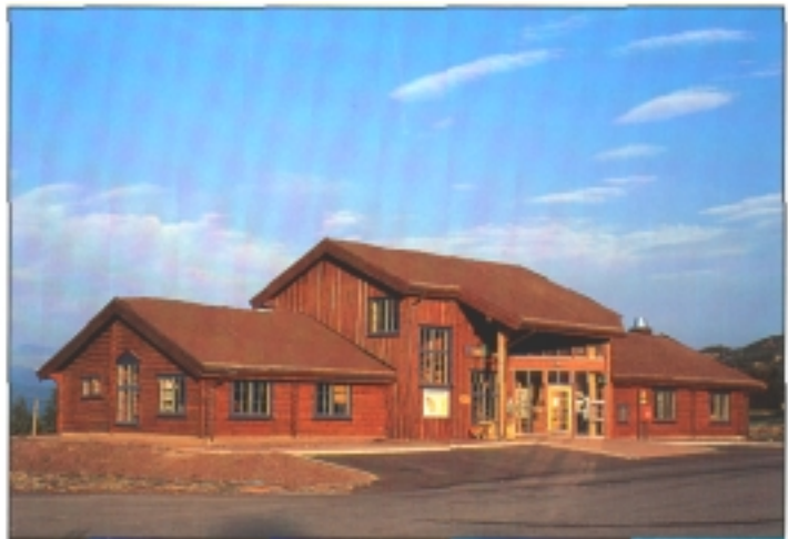
Eit fint døme på korleis ein også i dag kan kombinere ulike konstruksjonar, "tung" tømmervegg og "lett" vegg i bindingsverk og glas. Beitostølen i Øystre Slidre. Siv. arkitekt Hans Kr. Syvertsen. Foto: T.Ø.
