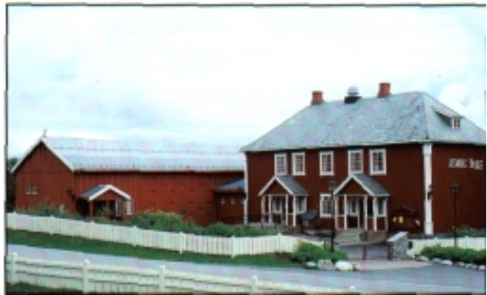
Tilbygget på Åsvang er stort, men har likevel underordna seg det gamle bygget. Nye materialar er innførte, men fargar bind saman det nye og det gamle. Siv. arkitekt Tore Kr. Guldbrandsen. Foto T.Ø.
