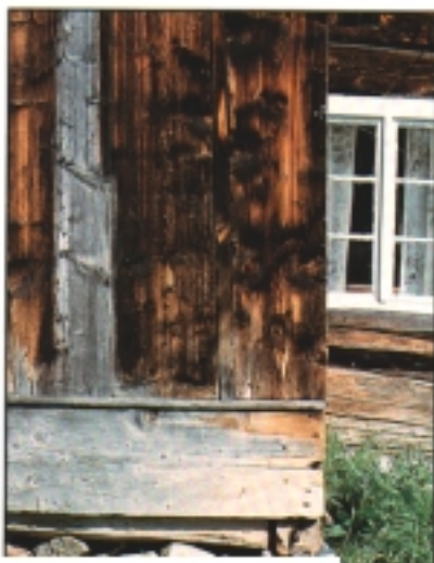
Panel med ei slett overflate. Bygning i Belseim. Foto: R.D.
