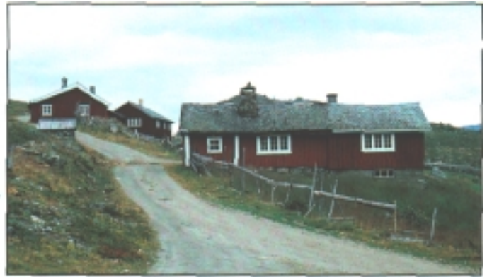
Sel i Strø, Vestre Slidre. Ein har fylgt tradisjonen med å byggje på i lengderetninga. Det er ulike typar panel og grunnmur, men farge og form bind det saman. Foto: R.D.
