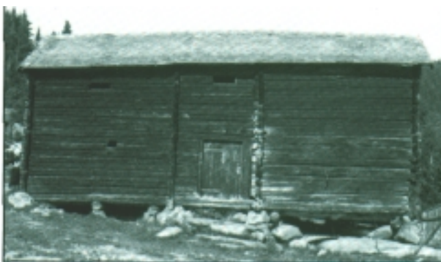
Bu/buahus i Kjøs med rektangulær plan, gang i midten og bu på kvar side. Foto: SEFRAK-reg.
