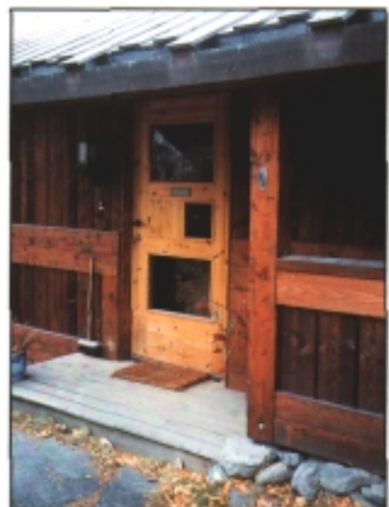
Triveleg inngangsparti: bearbeidd, men enkel, søyle og rekkverk. Hus i Nord-Aurdal. Siv.arkitekt Rune Urne. Foto: R.D.
