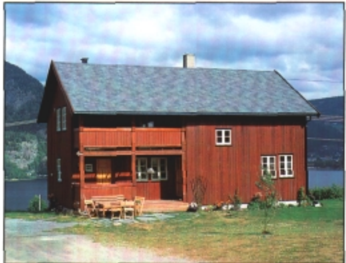
Av "gamle tema" kan ein har kjenne att den gode, enkle forma, ståande, slett trepanal, kombinasjon av "lukka" vegg og "open" sval. Hus på gardstun i Nord-Aurdal. Siv. arkitekt Ingrid Kvissel. Foto: T.Ø.
