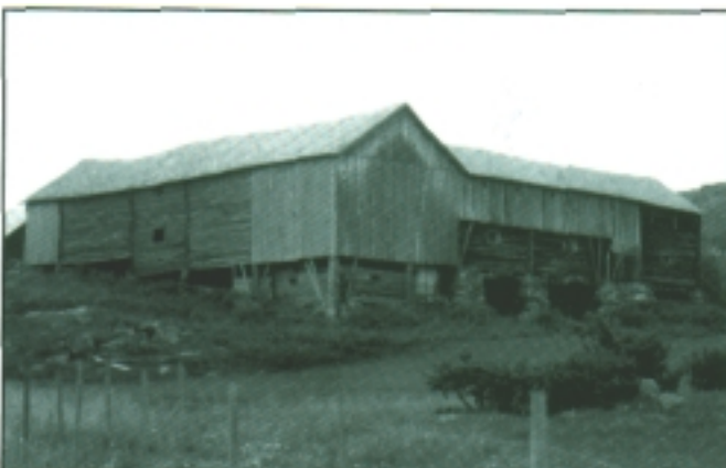
Uthuset på Kattevøl har plass til fleire dyreslag i eitt hus. Her kan me sjå at den gamle låven har vorte innlemma i den nye driftsbygningen. Foto: R. D.
