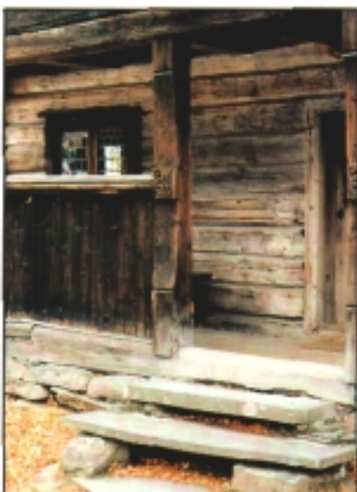
Svalstolpe og rekkverk, fint, men enkelt utforma. Gamle svalstolper i Valdres er firkanta . Bygning frå Sør-Aurdal. Foto:R.D.
