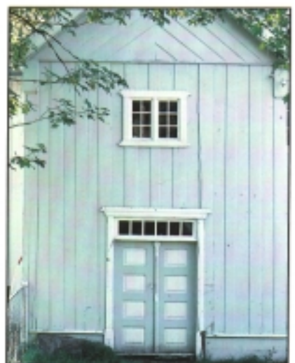
Inngangsparti i bygningen på Garstad, klassisk og enkelt. Foto: T.Ø.
