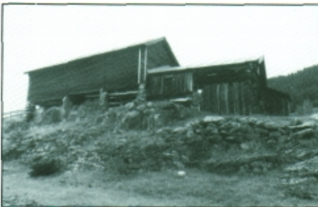
Tredelt låve og fjøs på Helle i Høre med gang i bindingsverk i mellom. "Tunge" laftekjerne, "lett" gang. Foto: T.Ø.
