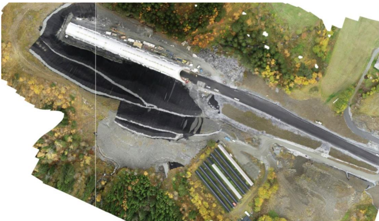
Figur 2 - Dronebilete over området før portalen vart fylt over
