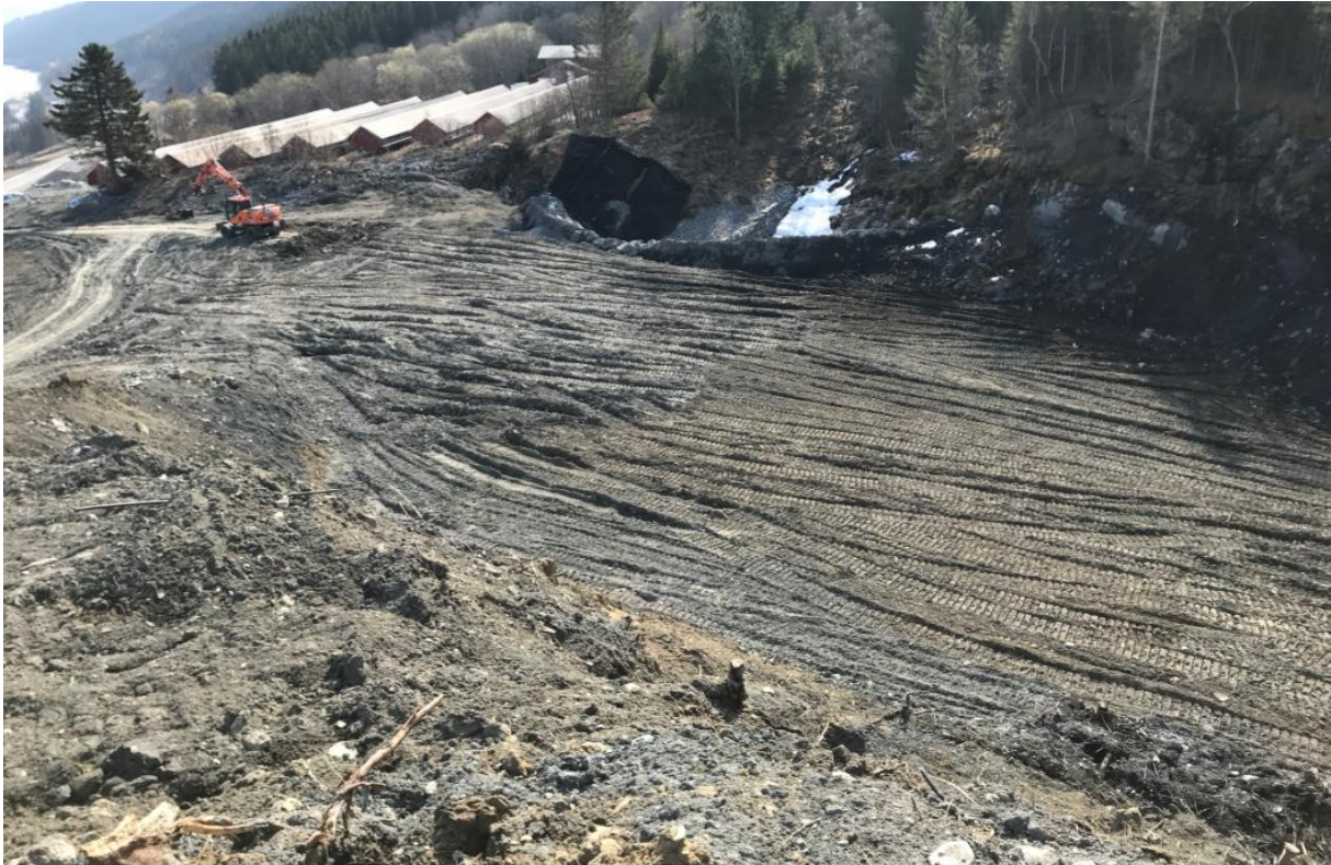
Figur 7 - Deponiområdet som det var 24.4.19. Det skal gravast ut drenering i austre del av området. Dette fører til høgare kant mot bygga. Foto: S. Aalbu, SVV
